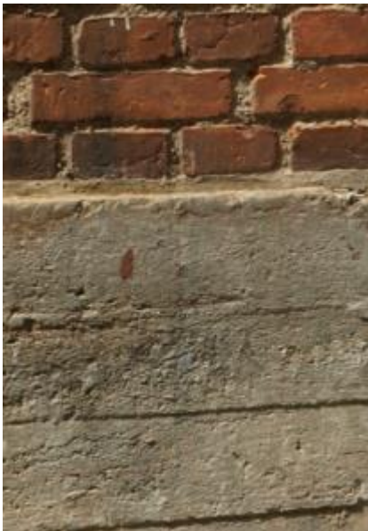
Kraftig sokkel i støbt beton, med synligt aftryk af bræddeforskalling, danner flot kontrast til de røde
