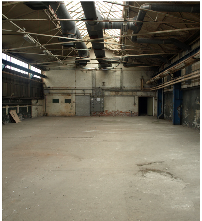
Betongulv i dag
