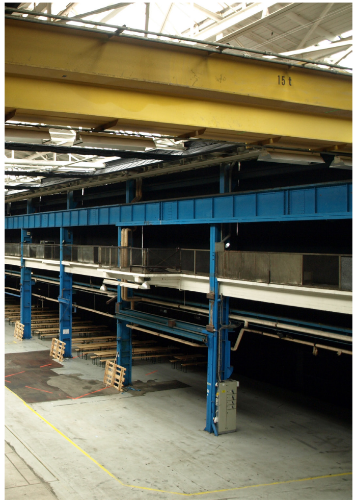
Stålkonstruktioner i Hal 14
